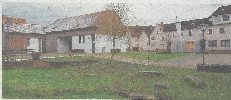
An dieser Stelle in Hofstetten soll das neue Begegnungshaus an das vorhandene Gebäude angebaut werden.
