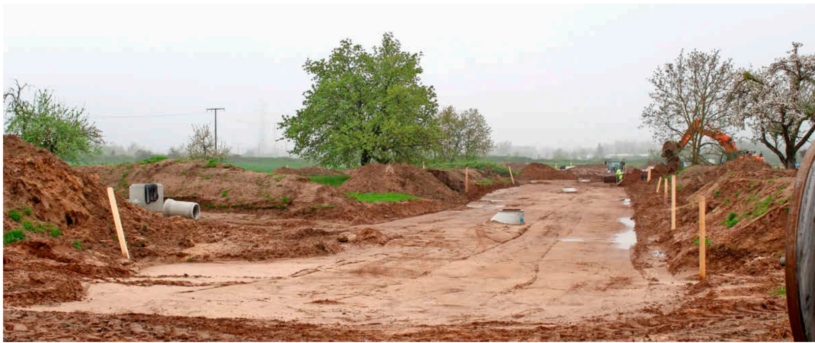
Die Erschließung des Neubaugebietes »Südlich Hofstetter Straße V« ist die größte Einzelmaßnahme im Kleinwallstädter Vermögenshaushalt.
