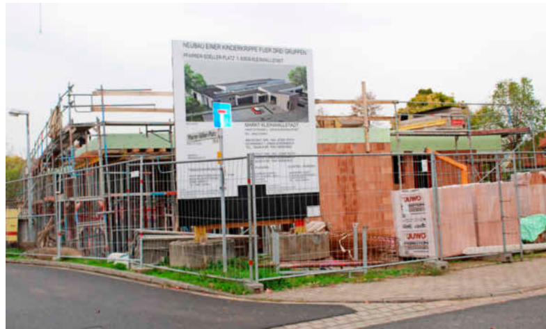
Der Krippen-Neubau in Kleinwallstadt verläuft planmäßig.
